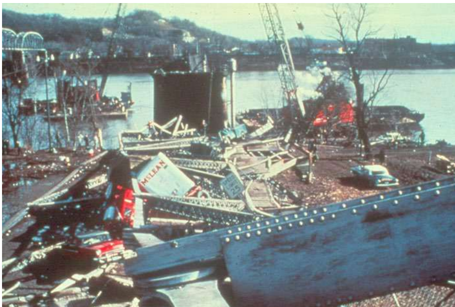
Рисунок 2 – Разрушение Серебряного моста, 1967 г. Фото из Bridge Inspector's Reference Manual (BIRM) (2022 NBIS)
