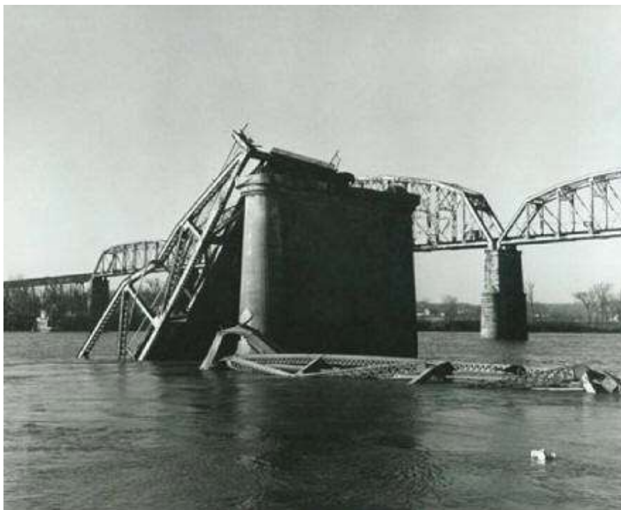
Рисунок 1 - Разрушение Серебряного моста, 1967 г Фото из открытых источников сети интернет
