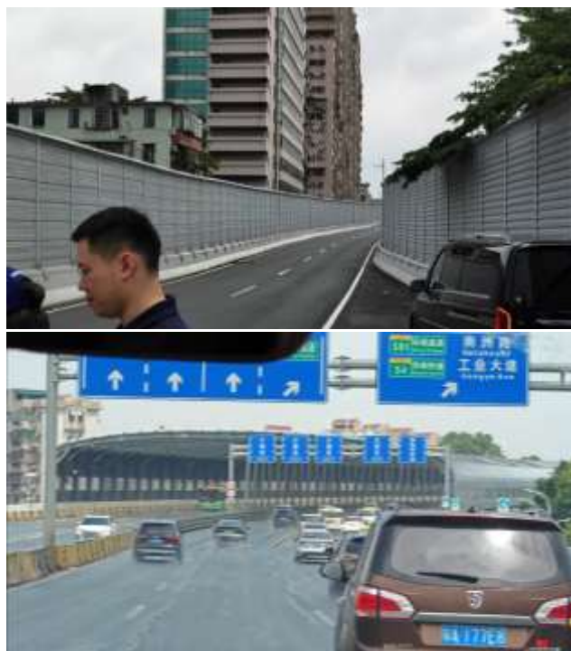
Шумозащитные экраны: а) экраны на барьерном ограждении; б) полностью закрытый экран моста Лоси
