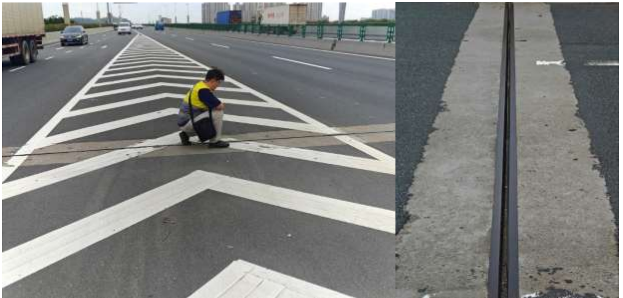
Деформационный шов открытого типа (г. Гуанчжоу)
