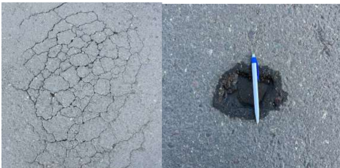
Сурет 6. Жолдың шаршауына байланысты жарықтар мен шұңқырлар
