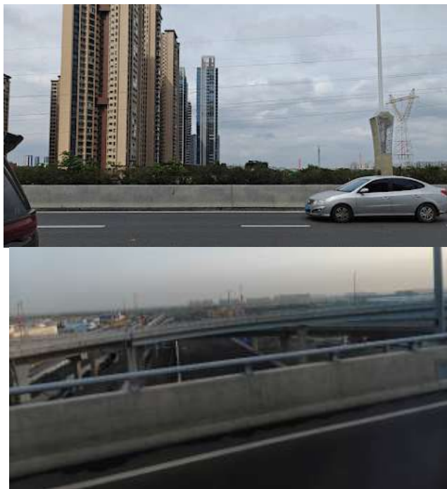
Барьерные ограждения типа «Нью-Джерси»: а) типовое; б) с дополнительным металлическим ограждением
