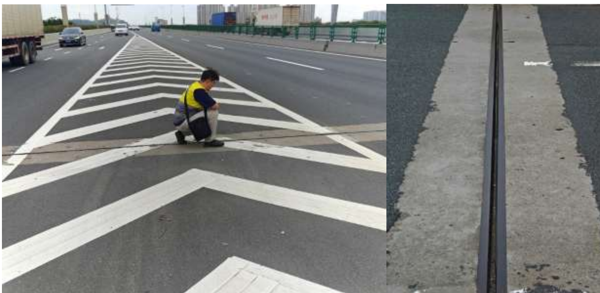
Деформационный шов открытого типа (г. Гуанчжоу)
