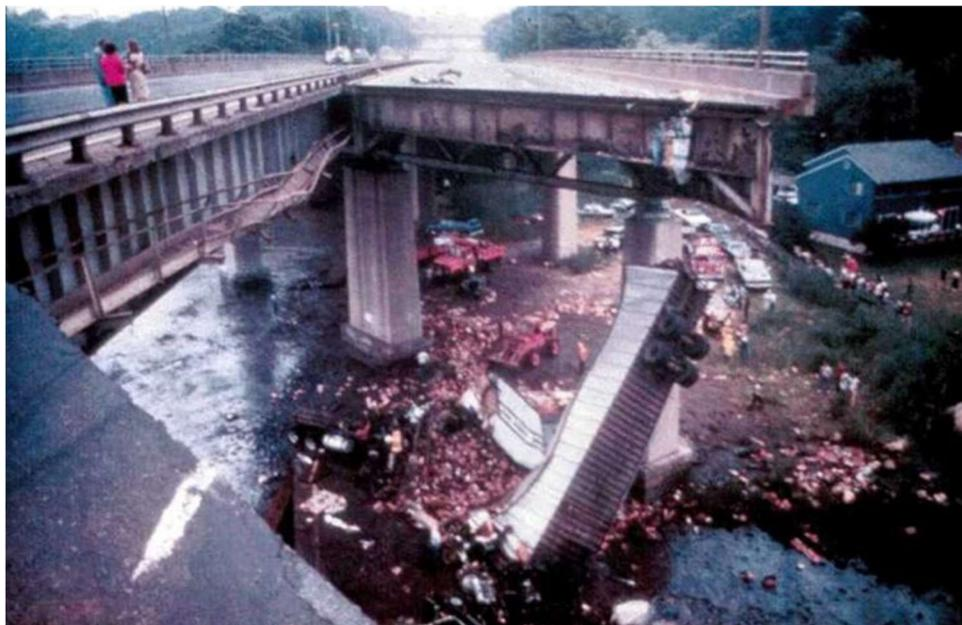
**Рисунок 3 – Разрушение моста Мианус**
